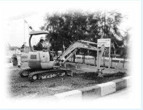
小型バックホーの掘削作業
