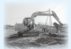
バックホー(0.25m 3 )による掘削作業
